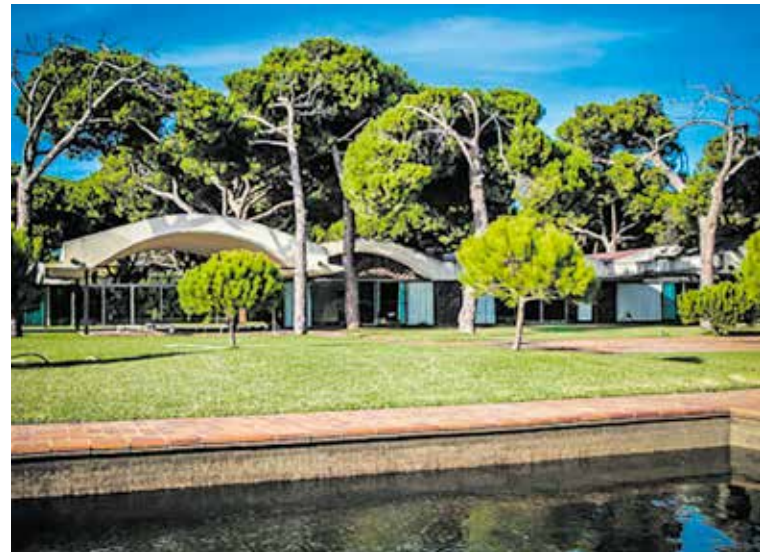
● La Casa Gomis està situada al paratge natural de la Ricarda
