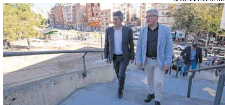
● Los alcaldes de L'Hospitalet y Esplugues han visitado las obras esta semana
